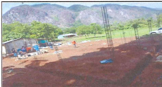
Foto 1: en esta imagen se aprecia la fundición de las bases y columnas en la rehabilitación de paredes de la escuela.
