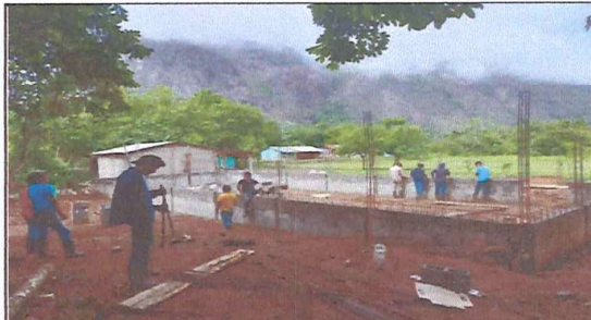
Foto 2: en esta otra fotografía ya se habían pegado 5 hiladas de block, juntamente con su solera respectiva.
