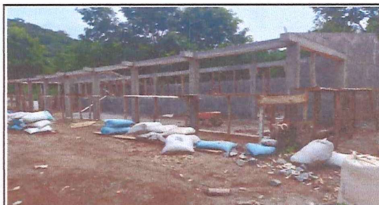
Foto 4: aca se puede apreciar que ya se había concluido con el pegado de block de las paredes, así mismo con la incorporación de las columnas del corredor de la escuela, como también de los mojinets para posteriormente colocar la estructura metálica.
