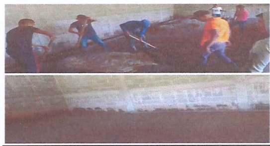
Foto 6: iniciando con el remozamiento del piso.
