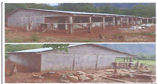
Foto 5: en esta otra imagen se visualiza la puesta de la cubierta y estructura metálica y enlaminado.
