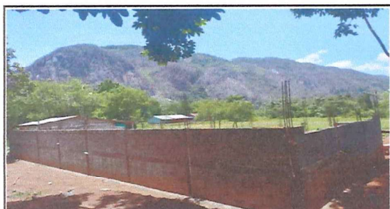
Foto 3: en esta imagen ya se había avanzado con 5 hiladas mas de block despues de la primera solera.
